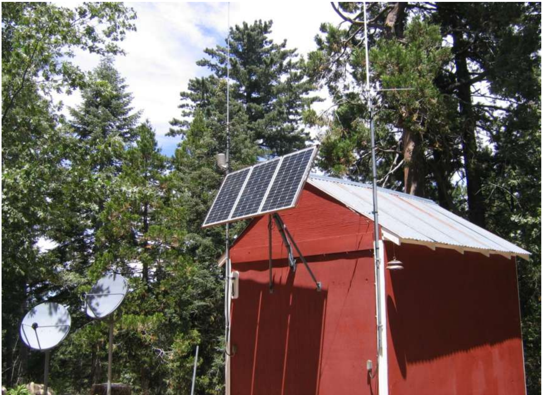
Hegyen települt átjátszó állomás napelem táplálással
